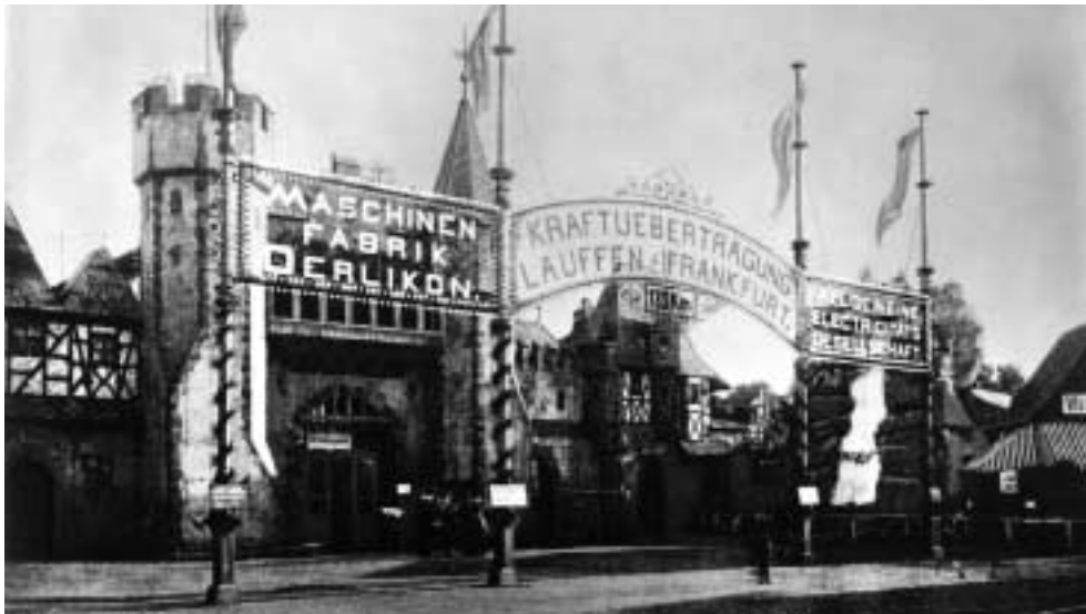
Abb.17: Drehstromübertragung von Lauffen nach Frankfurt, 1891. Auf der internationalen elektrotechnischen Ausstellung in Frankfurt speiste Drehstrom, der in Lauffen erzeugt wurde, einen 100 PS Induktionsmotor für den Wasserfall im Hintergrund des Bildes und die 1000 Glühlampen des Werbeschildes.
