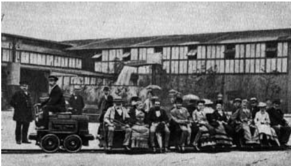
Abb.4: Mit einem Gleichstrommotor betriebene elektrische Bahn, die Siemens 1879 auf der Berliner Gewerbeausstellung präsentierte.
