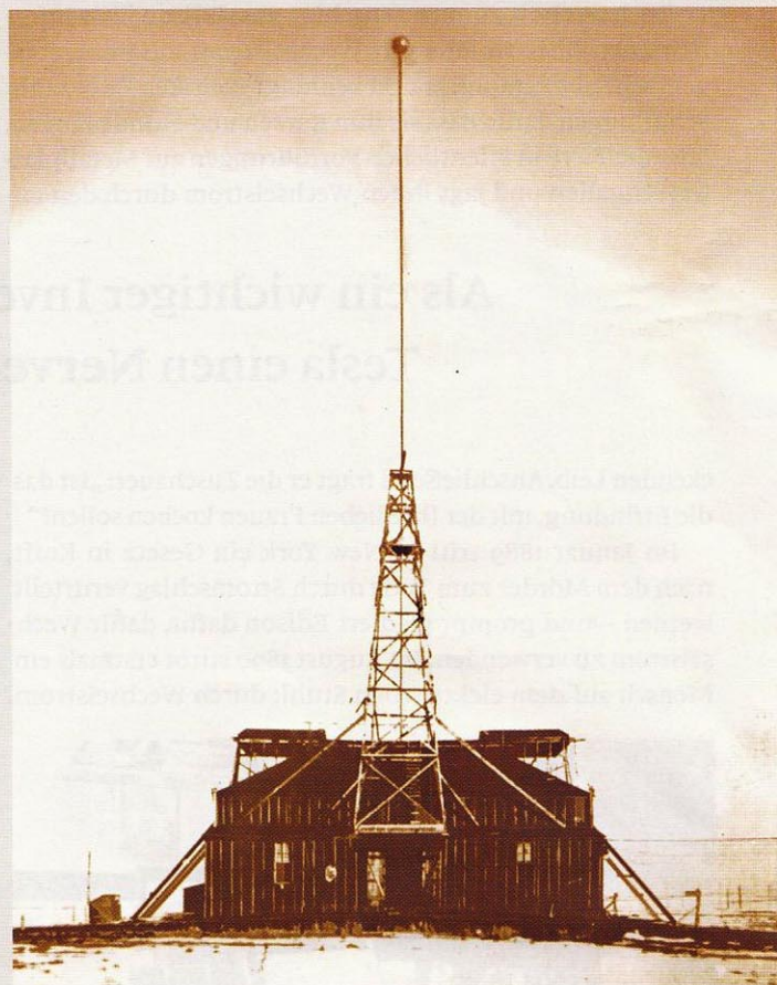
Eine Metallkugel krönt den 45 Meter hohen Mast von Teslas Versuchsstation in der Wüste bei Colorado Springs. Mit der Anlage erzeugt der Erfinder gewaltige Blitze und Radiowellen, um die elektrischen Kräfte zu erforschen und nutzbar zu machen
