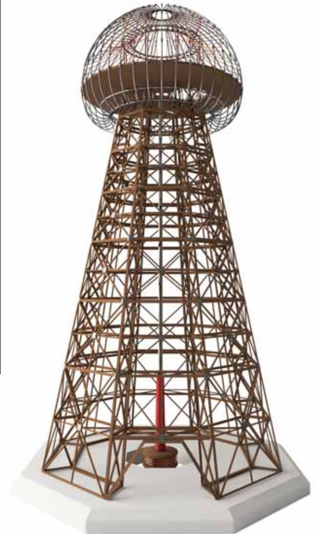
Tesla-Turm zur drahtlosen Übertragung von Strom
